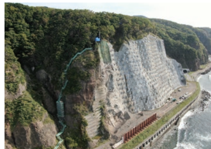
国道336号 法面対策
