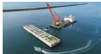
浦河港本港地区西島内港防波堤整備状況
