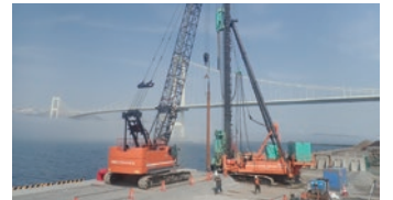
室蘭祝津絵鞆地区水深11m岸壁改良整備状況
