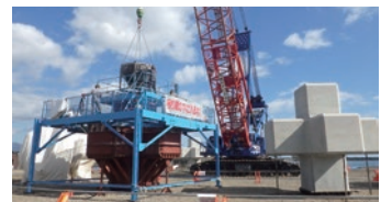
白老港本港地区島防波堤整備状況
