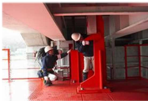
【ダム堤体・放流設備等の点検整備】
