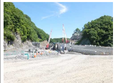
平取ダム堤体建設工事 全景
