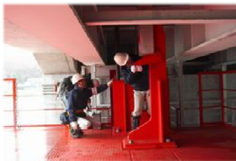
【ダム堤体・放流設備等の点検整備】
