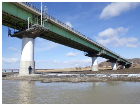
【耐震補強（下部工補強）】
