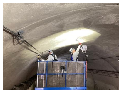
【道路トンネル点検】
