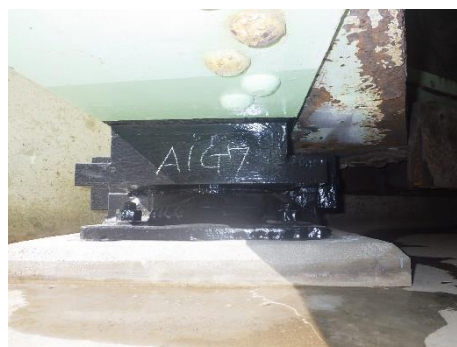
【橋梁補修後（支承）】
