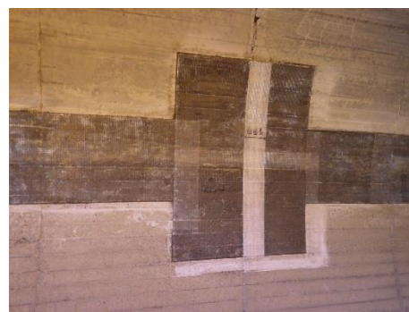
【道路トンネル補修後】
