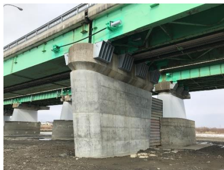
【耐震補強（落橋防止工）】
