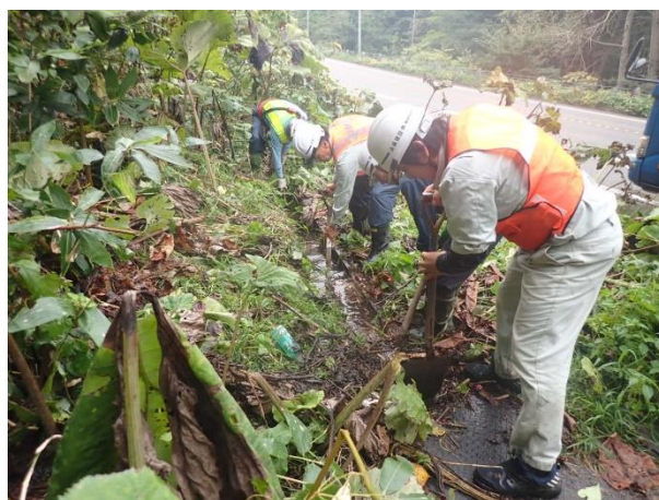
【排水構造物清掃】
