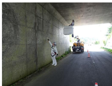
【大型カルバート点検】
