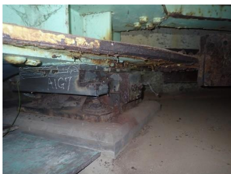
【橋梁補修前（支承）】
