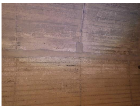
【道路トンネル補修前】
