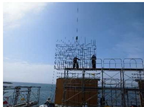
鉄筋・型枠組立
