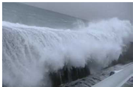
防波護岸からの越波 (平成28年1月)
