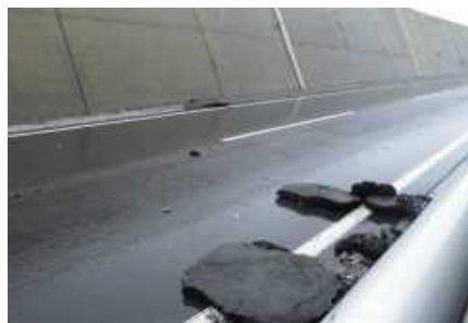
越波による 道路舗装の剥離・飛散
