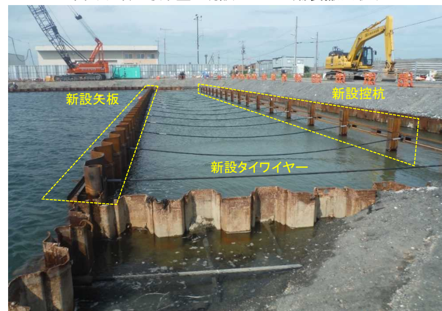
船だまり-3M物揚場 新設矢板及び控杭打設完了状況
