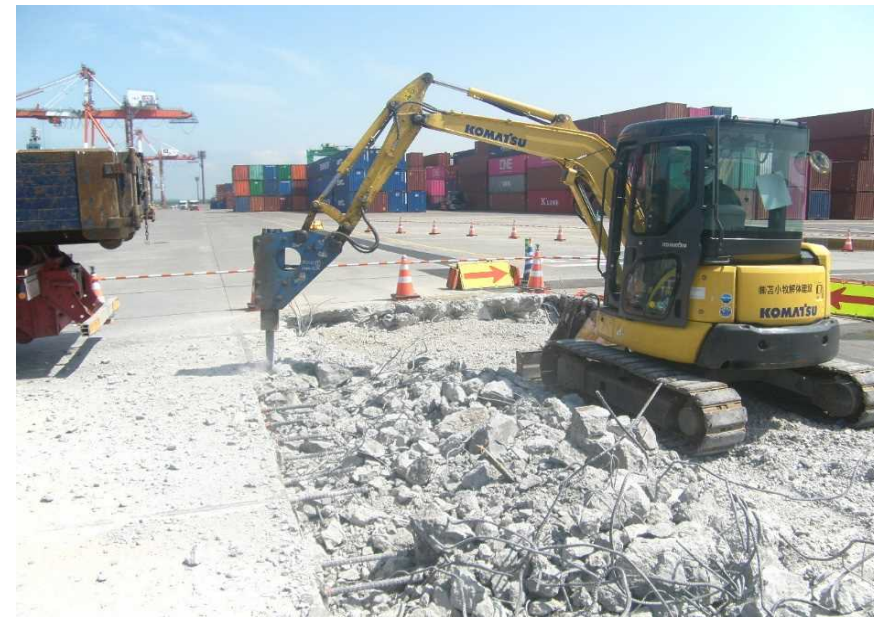
中央ふ頭2号岸壁 既設エプロン舗装撤去状況
