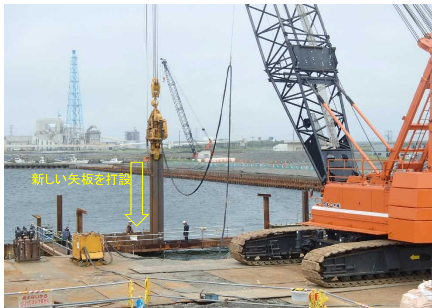
船だまり-4M物揚場 矢板打設状況
