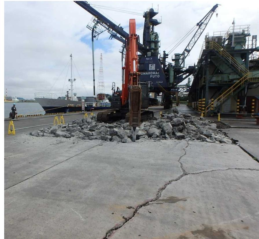
中央南埠頭1・2号岸壁 既設エプロン舗装撤去状況
