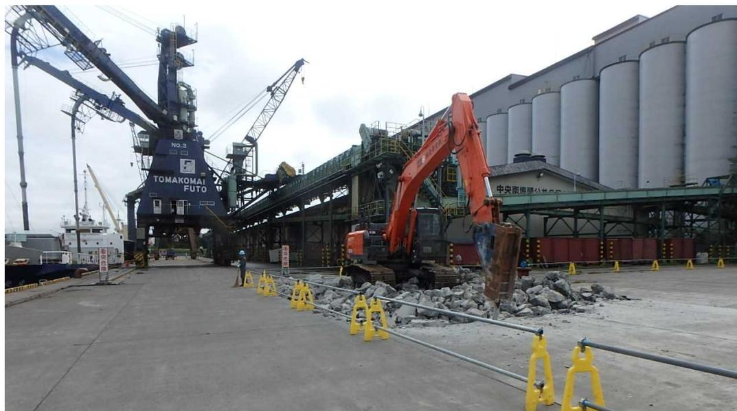
中央南埠頭1・2号岸壁 既設エプロン舗装撤去状況
