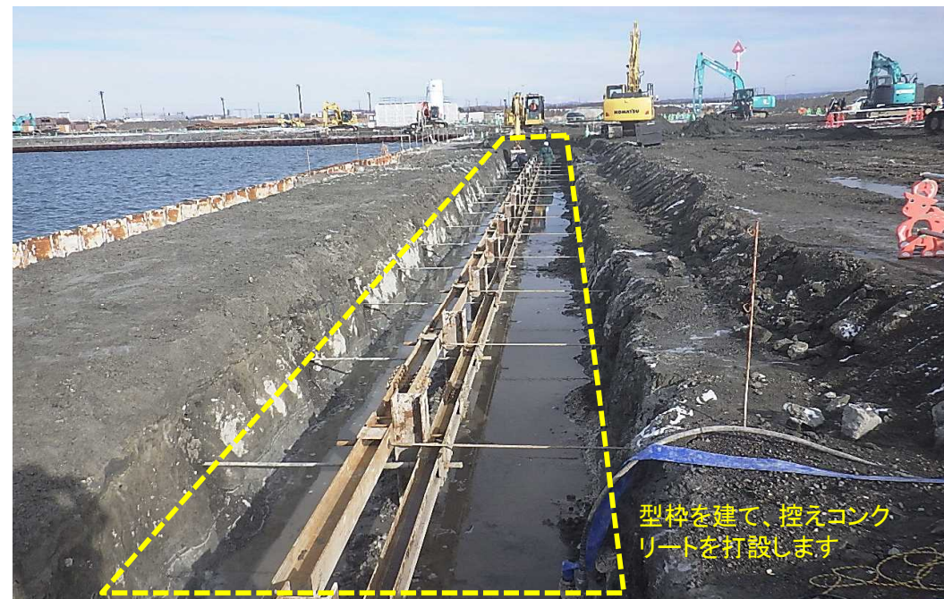
船だまり-4M物揚場 控え工施工状況
