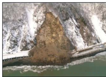
H16.1月 斜面崩落
