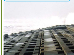
写真奥側の直立護岸は波の打ち上げが高い
