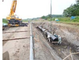
追分幹線用水路工事
