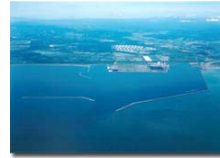
苫小牧港（東港区）
