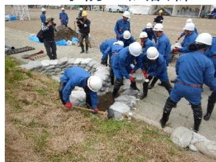
漏水対策工法（月の輪工）
