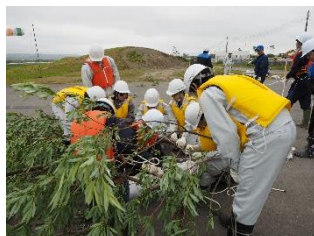
大学、高等専門学校による洗掘対策工法（木流し工）
