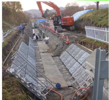
川東幹線用水路の復旧(むかわ町)
