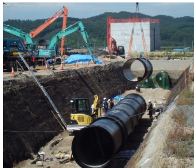
厚幌導水路の復旧(厚真町)
