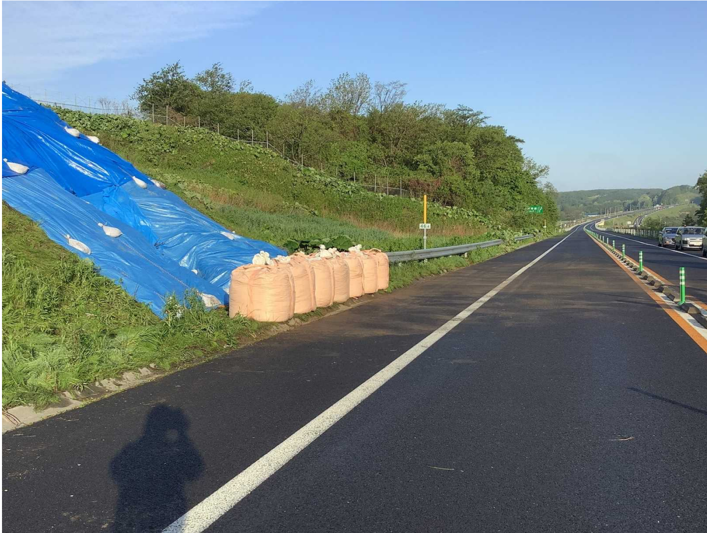
日高自動車道（日高門別 I C～日高厚賀 I C） 復旧作業完了状況
