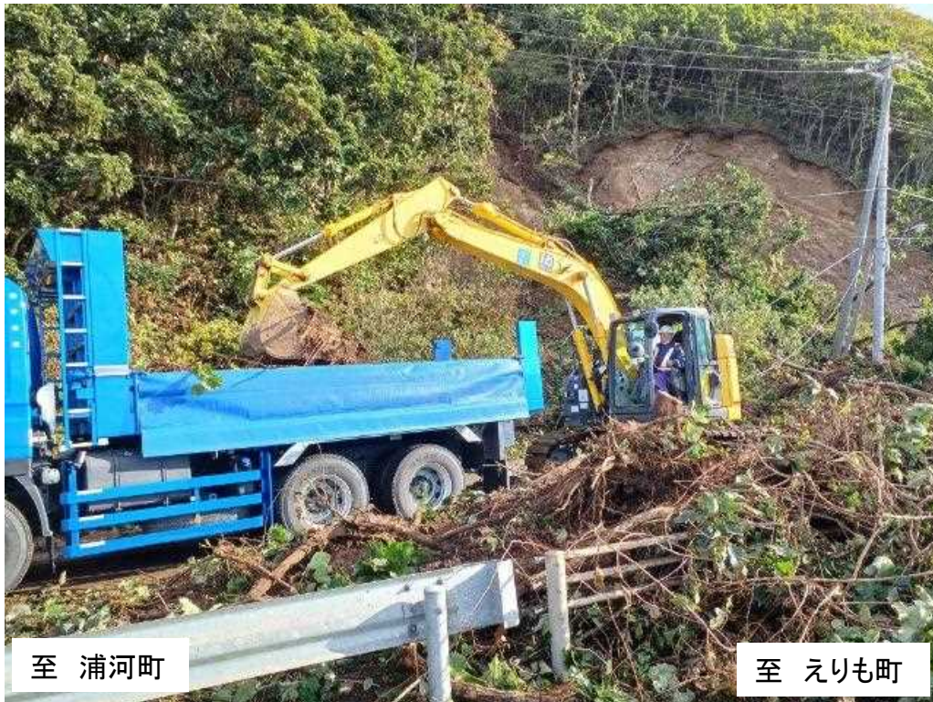
さまにちょうあざうとま (①) 国道336号 様似町字鶺鴒 応急復旧作業状況 (10月7日7:40時点)
