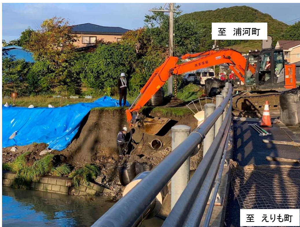
さまにちょうかんべつばし (③) 国道336号 様似町寒別橋 応急復旧作業状況 (10月7日6:45時点)
