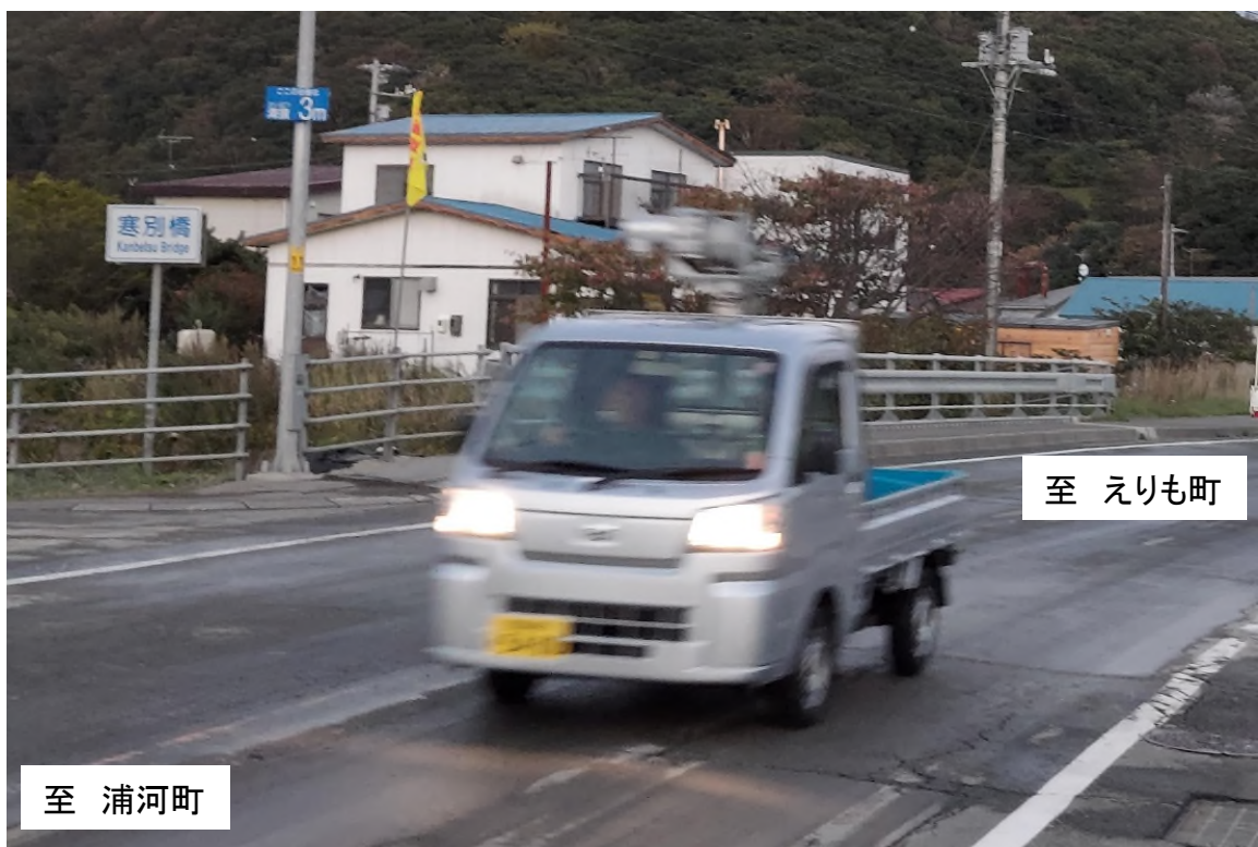
(③) 10月8日 国道336号 さまにちょうかんべつばし 様似町寒別橋 埋め戻し作業完了状況
