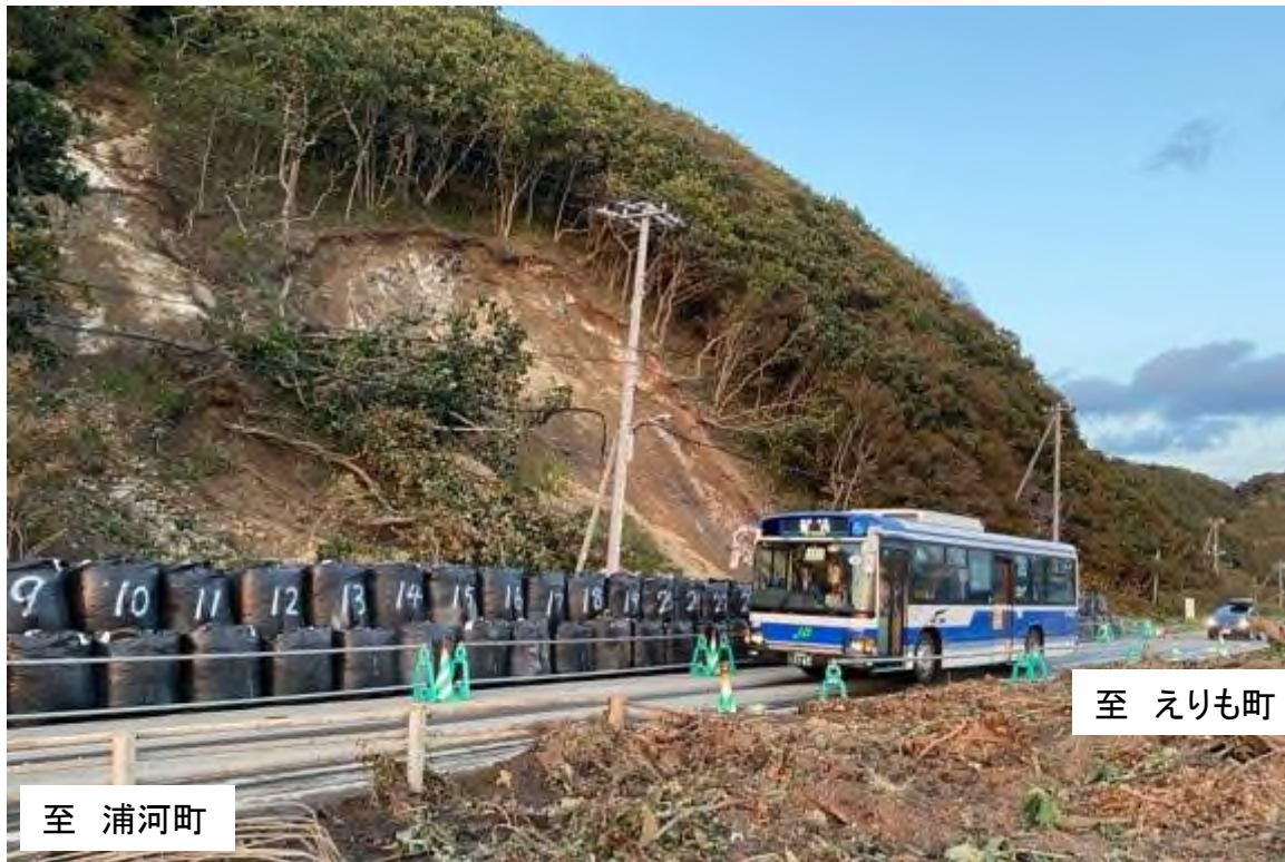
(①) 10月8日 国道336号 さまにちょうあざうとま 様似町字鵜苫 大型土のう設置完了状況
