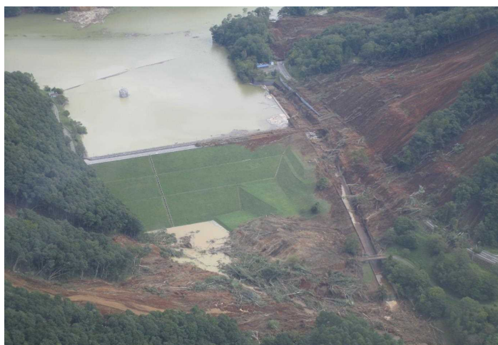
発災翌日の被災状況(H30.9.7)
