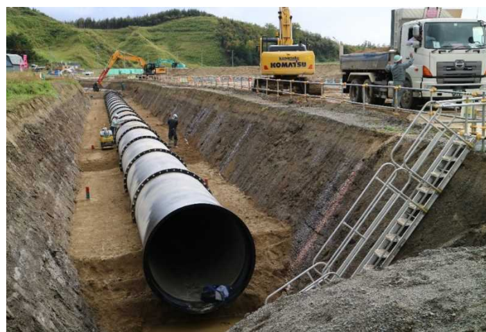
復旧工事の状況(R2)
