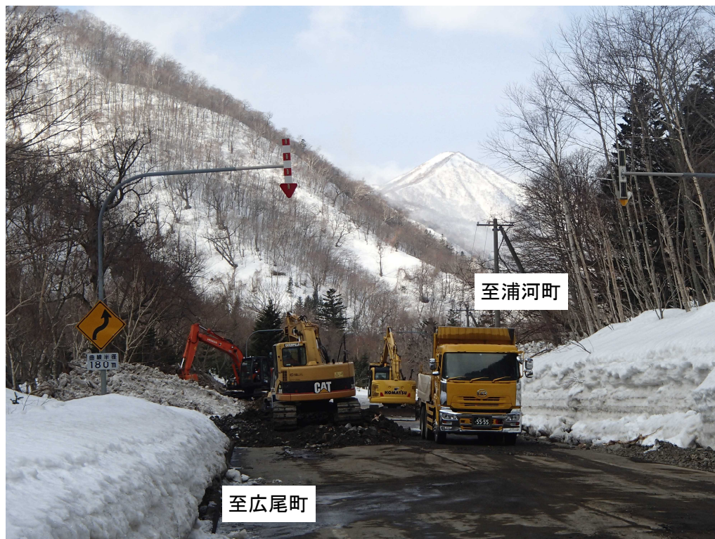
▲土砂撤去状況 (3月11日撮影)
