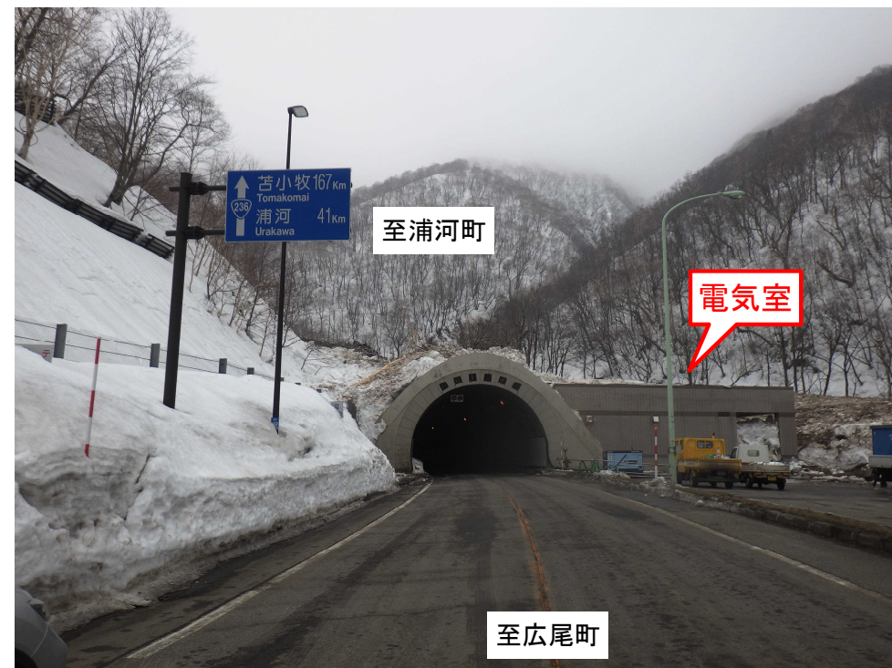
▲車道除雪完了状況 (3月15日撮影)
