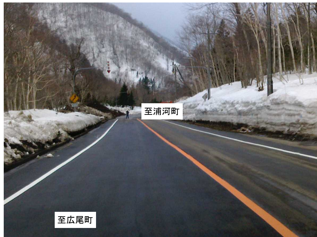
▲舗装補修完了状況 (3月13日撮影)
