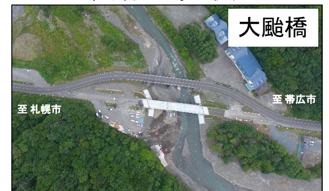
平成30年8月現在 ＜架け替え工事の状況＞
