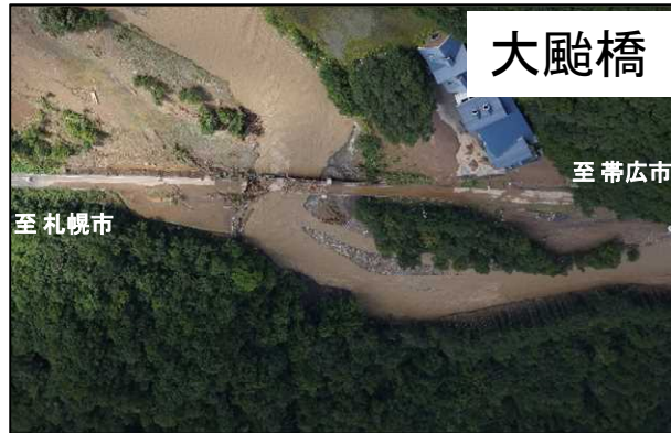
平成28年8月30日被災 ＜被災状況＞
