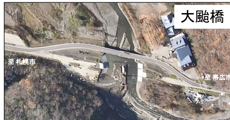
平成29年10月全面通行止め解除 ＜迂回路の状況＞
