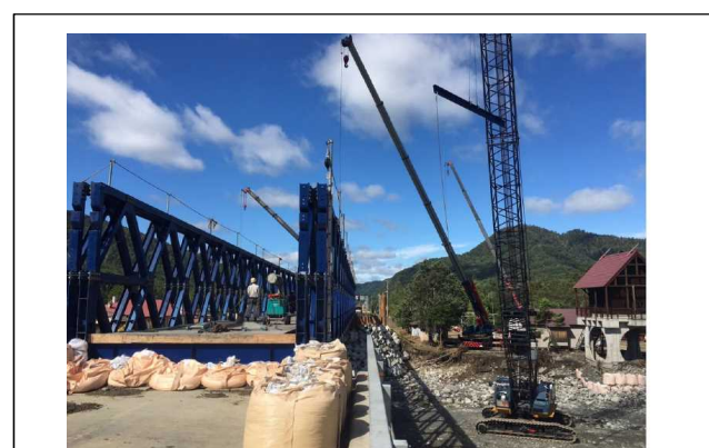
復旧状況 (仮橋架設状況)
