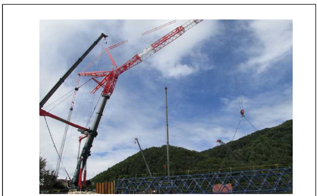
復旧状況 (仮橋架設状況)
