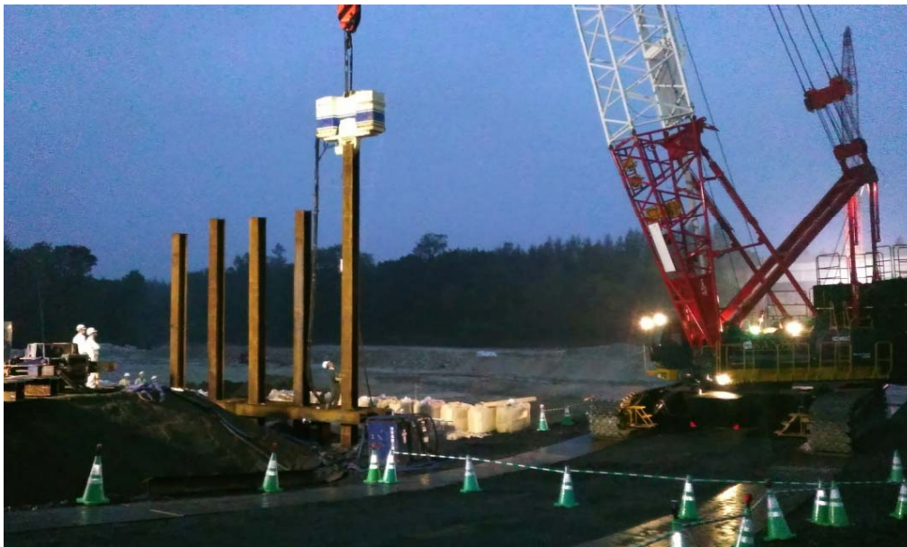
復旧状況【夜間】 ～クレーンによる仮橋設置状況～
