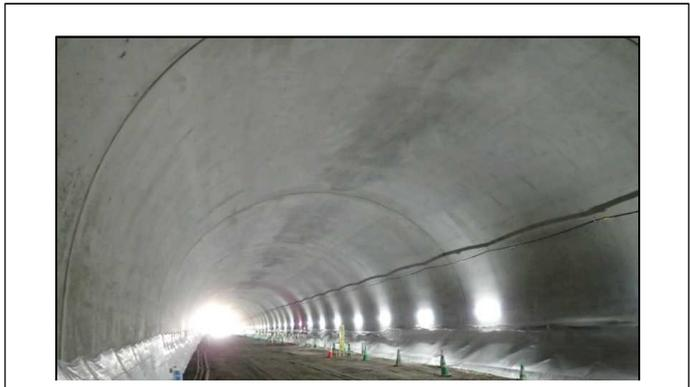
3月にトンネルの掘削が終了(貫通)したので、今年は覆工の状況を見てもらいます。(写真は覆工完成部)
