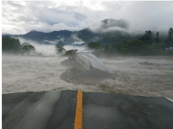
△落橋状況(H28.8.31)
