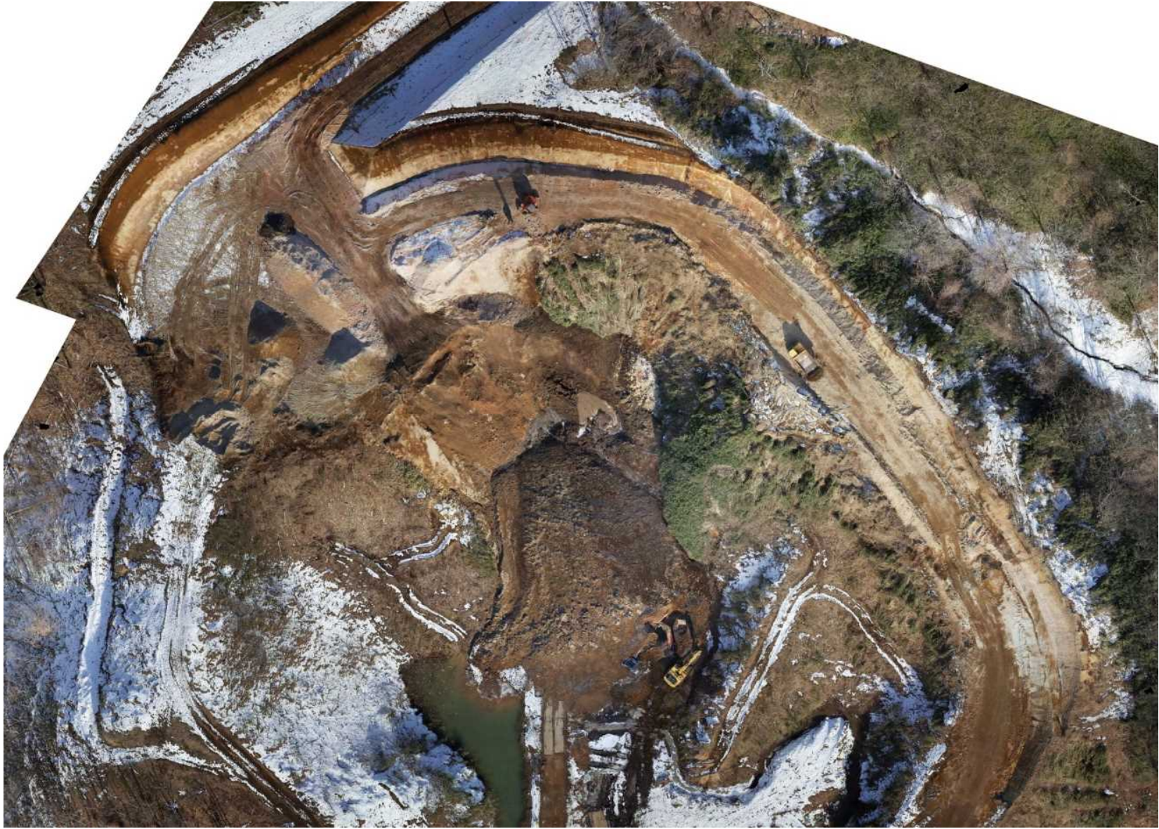
写真 2. 崩落箇所周辺の状況 (H28. 1. 10 撮影)
