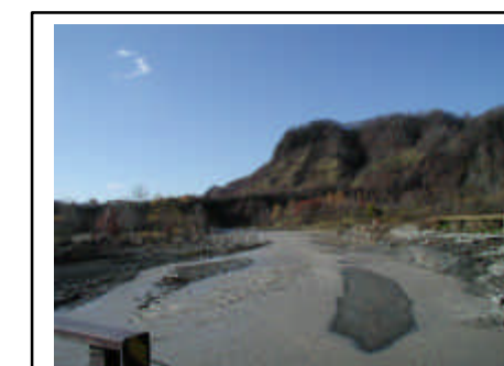
豊糠橋からダム堤体方向を望む(秋) 額平川右岸に連続する崖地が象徴的な景観を形成している。
