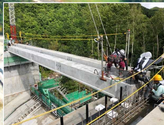
天端橋梁施行状況 (R2. 9)
