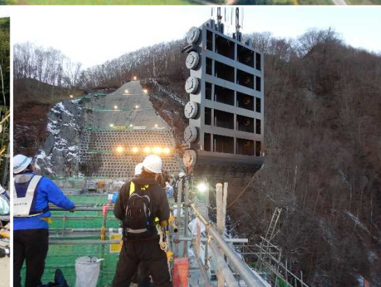
常用洪水吐きゲート据付状況 (R2. 12)
