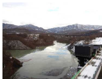
洪水貯留準備水位超過状況 (令和3年11月25日)
