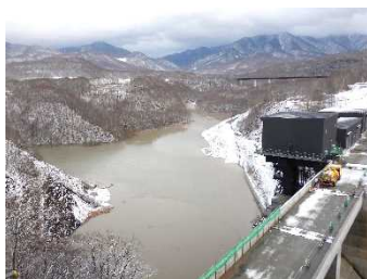
試験湛水開始状況 (令和3年11月24日)
