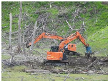
伐採作業(令和6年)
