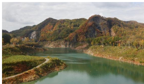
湛水時（令和7年10月17日）
