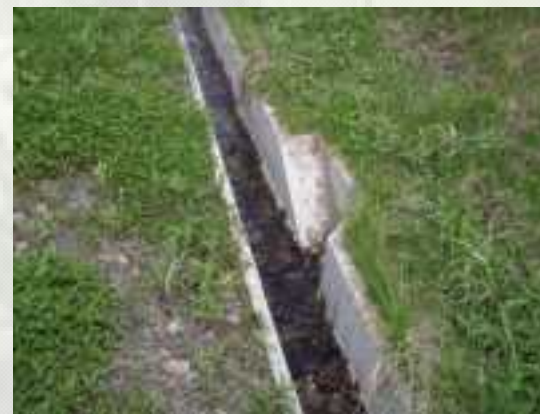
落下した小動物等の脱出対策 (スロープ付き道路側溝の設置)
