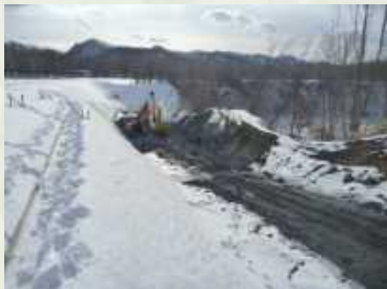
工事用道路工事
