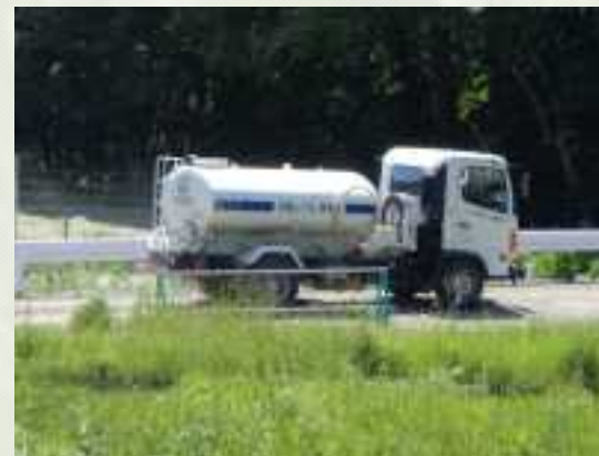
粉じんの低減 (非舗装路面への散水)
