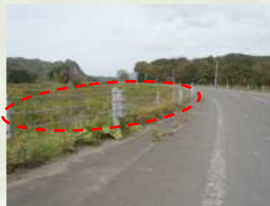
すずらん群生地周辺の眺望景観を阻害しないため、展望快適性に優れているガードケーブルを採用
