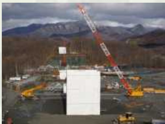
豊糠橋下部工事
