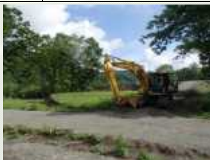
作業終了後に残置 した建設機械 H26/6/16
