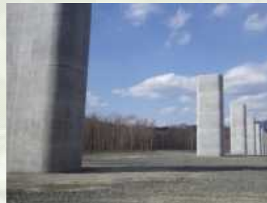
構造物の意匠 (コンクリート構造物のラウンディング処理)
