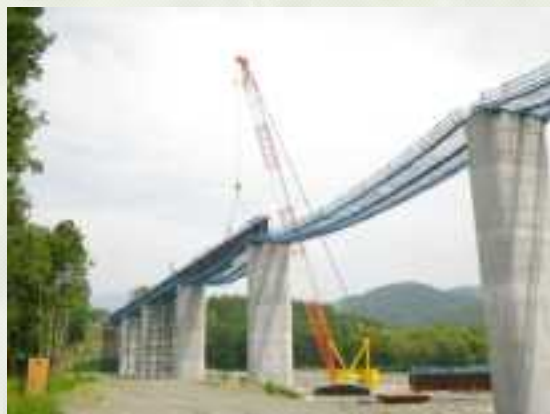
豊糠橋上部製作輸送架設工事
