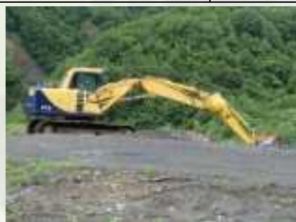
着工当初に使用した 建設機械(バックホウ) H26/6/14
