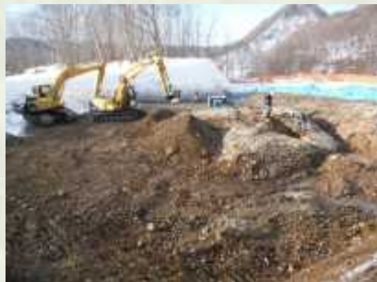
粗基礎掘削工事
