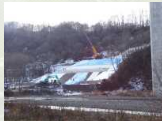
斜面对策工事
