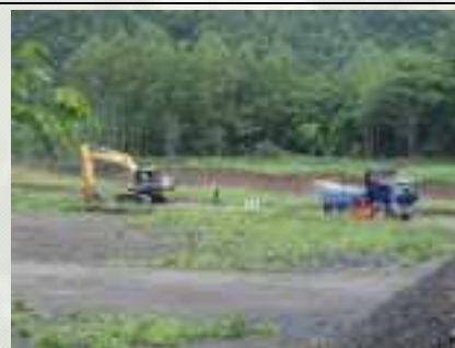
規制解除後の作業 H26/6/19
