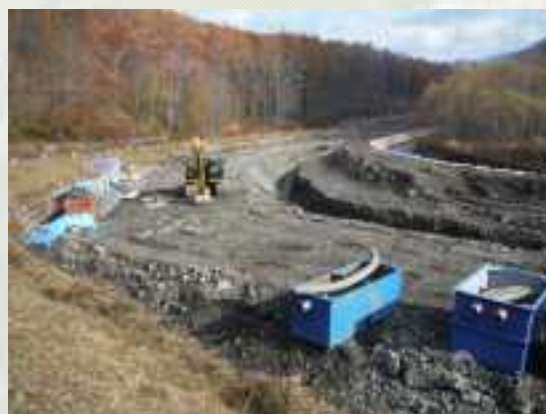
付替町道芽生すずらん線工事
