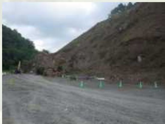
基礎掘削工事
