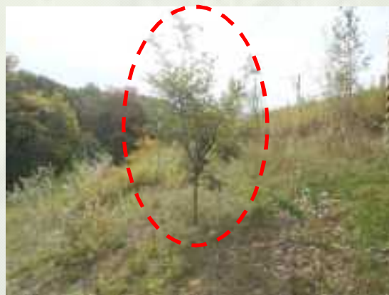
周辺景観との調和を図るため、工事後の盛土法面へ植栽した落葉広葉樹
