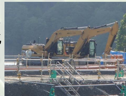
作業終了後に残置した建設機械
