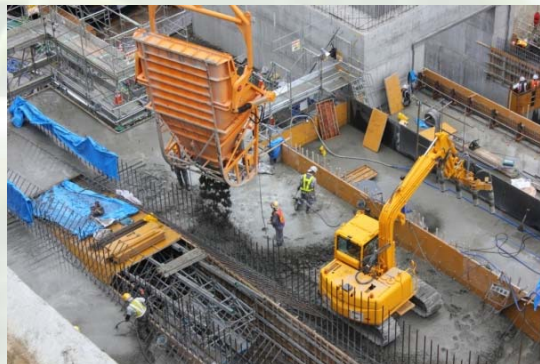
コンクリート打設工
