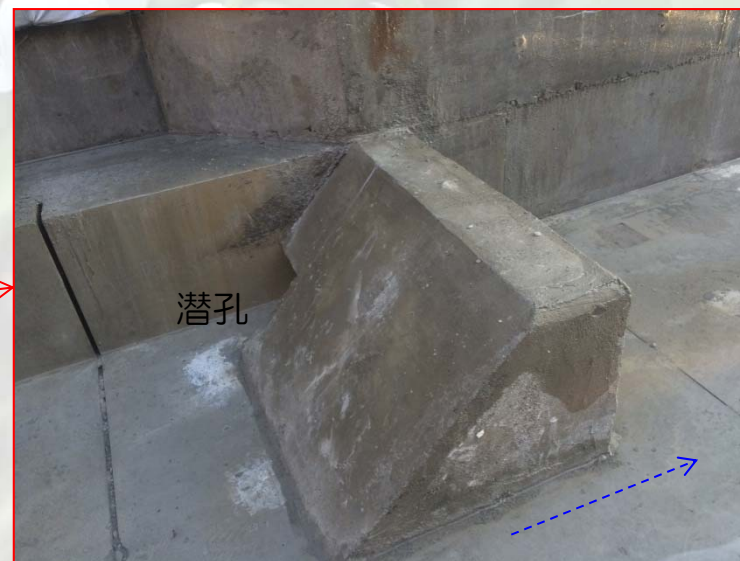
設置した水制
