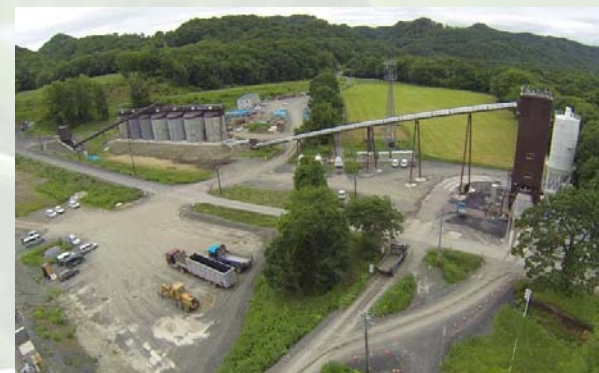
コンクリート製造設備
