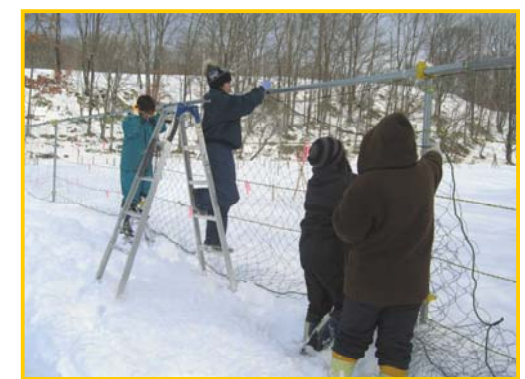
◆モデル地区（S-05）シカ防護ネット張り作業
