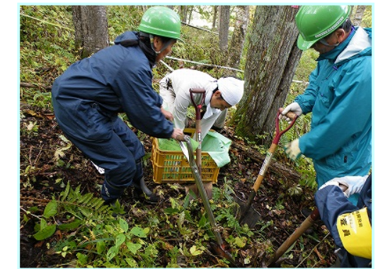
◆付替道路工事箇所の草本ブロック移植作業
