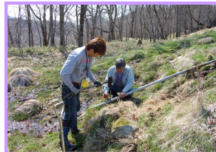
◆小屋跡付近にあるかつて利用した湧き水の整備
