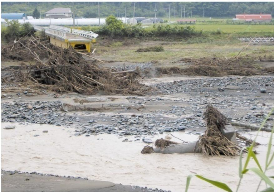
写真－3 流木により流出した橋梁(二風谷ダム上流(額平川))
