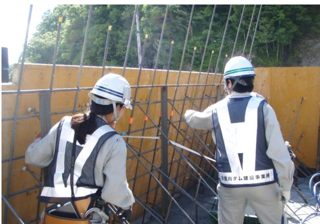
平取ダム堤体建設工事 堤体鉄筋確認
