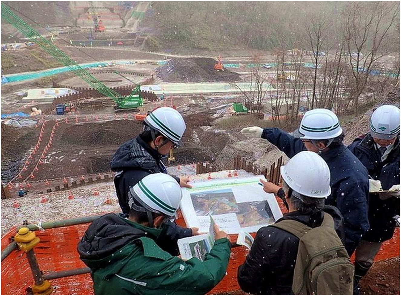
樽前山直轄火山砂防事業の工事現場を報道機関に公開
