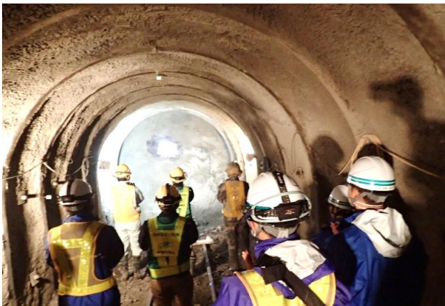
厚幌導水路隧道の貫通立会
