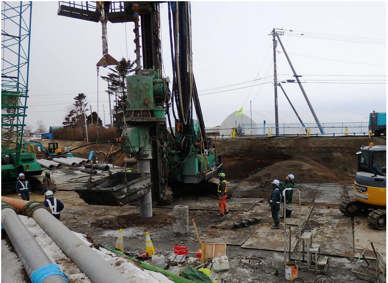
新鷗川地区田浦第2幹線排水路工事 現地立会
