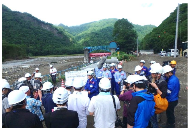
国道274号の復旧作業状況を報道機関に公開
