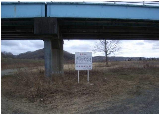
⑦平取橋（橋下敷地）（1） KP17.2
