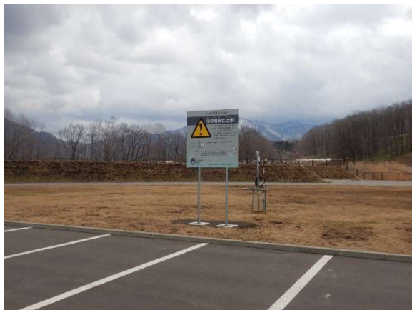
①平取ダム電源棟（1） K P 2 2 . 4
