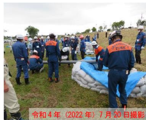
写真 2-35 月の輪工法
