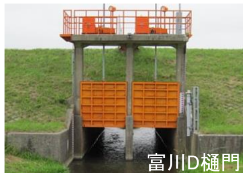
浸水軽減対策(樋門の無動力化前)
