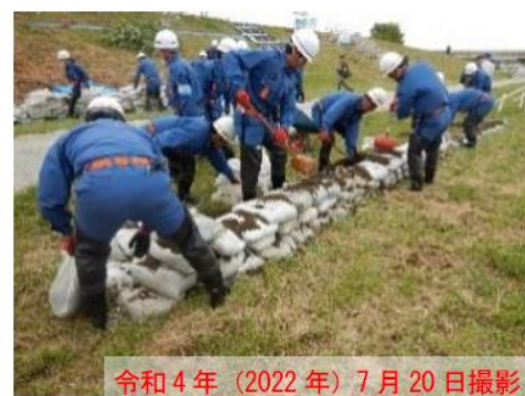
写真 2-33 防災機関による積み土のう工
