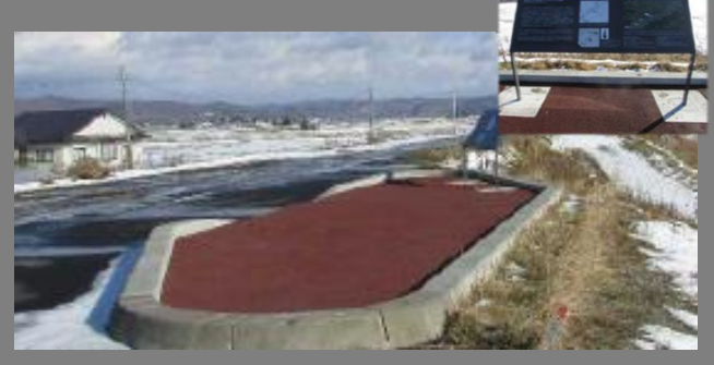
②視点場（側帯盛土）の整備
