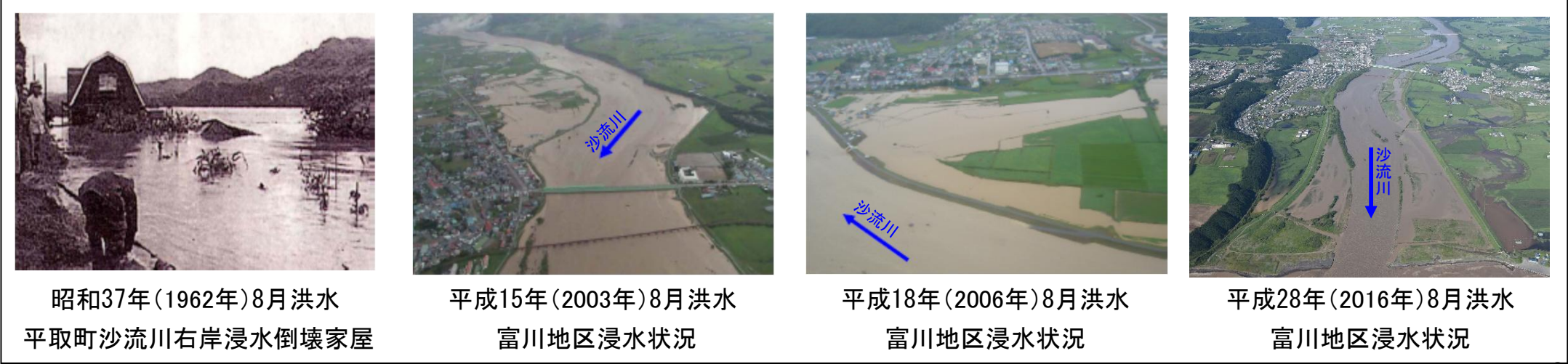
図 2－6 洪水被害状況
