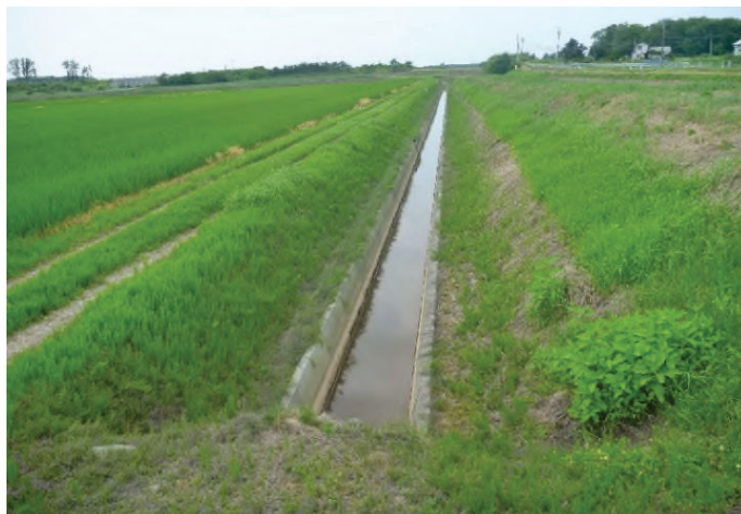
農業排水路の整備
