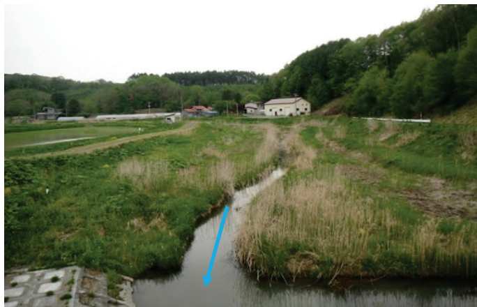
（ウクル川）河道掘削等の実施
