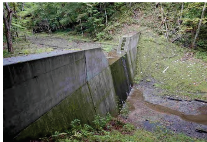
道有林内における治山ダムの整備
