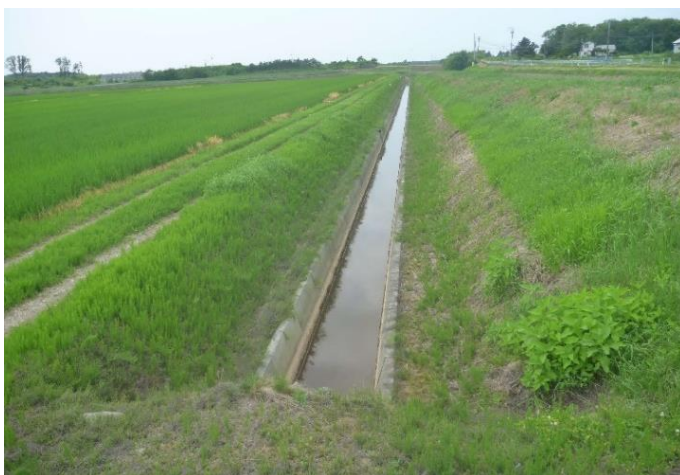
農業排水路の整備
