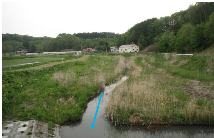
（ウクル川）河道掘削等の実施
