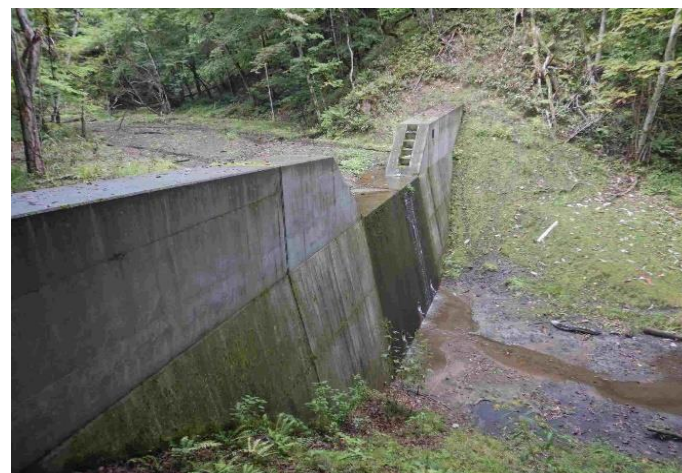
道有林内における治山ダムの整備
