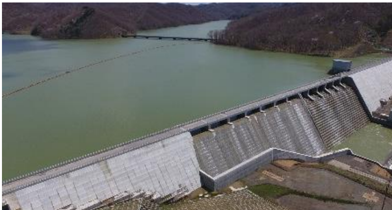
厚幌ダム (胆振総合振興局、室蘭開発建設部、厚真町、厚真町土地改良区)
