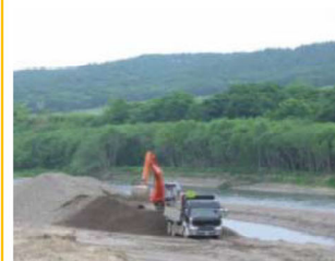
河道掘削した土砂を、
