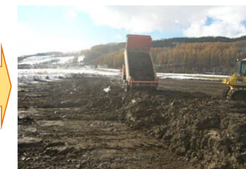
土砂が流出した農地へ運搬し、
