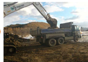
ダンプトラックへ積み込み、
