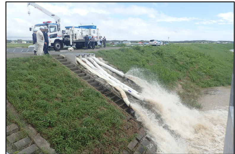
汐見樋門 ポンプ車排水状況 (平成28年(2016年)8月洪水)
