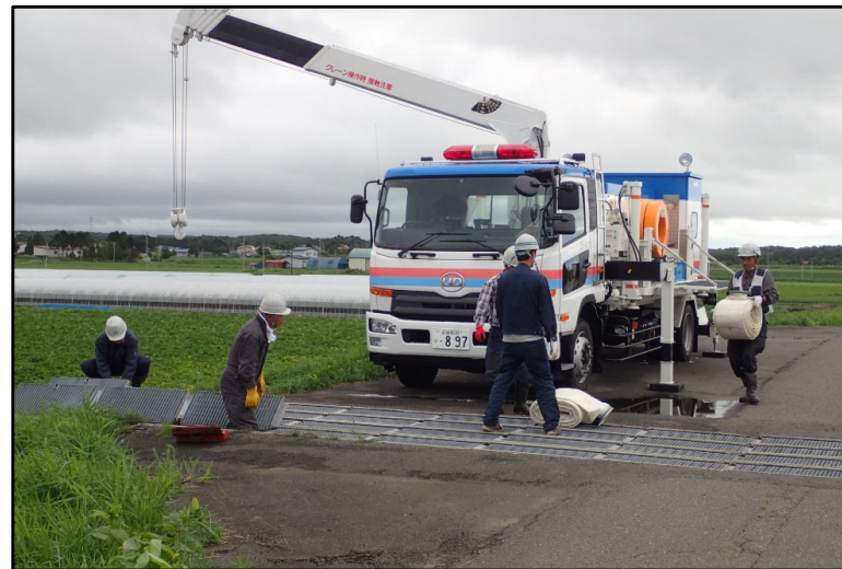
ポンプ車による内水排除の状況 (汐見樋門、平成28年(2016年)8月洪水)
