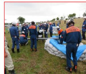
写真 2-35 月の輪工法
