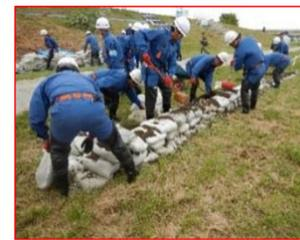
写真 2-33 防災機関による積み土のう工
