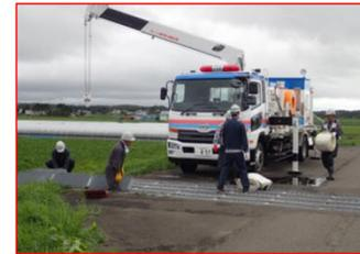
写真 2-1 ポンプ車による内水排除の状況
