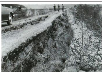
豊城築堤 堤防のすべり破壊
