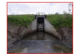
写真 2-32 堆積土砂掘削後
