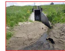
写真 2-31 堆積土砂掘削前
