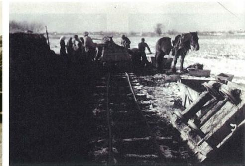
写真 1-6 馬トロによる築堤盛土(豊城築堤)
