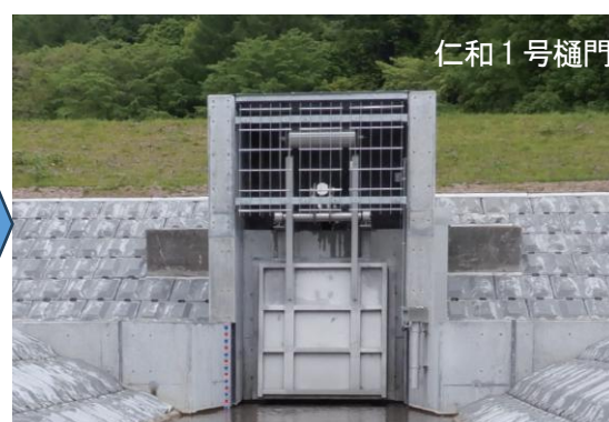
写真 2-4 浸水軽減対策（樋門の無動力化後）
