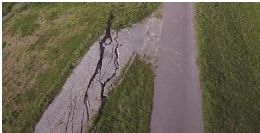
出典：北海道開発局 写真 1-24 河口左岸築堤の亀裂 (平成30年(2018年)北海道胆振東部地震)
