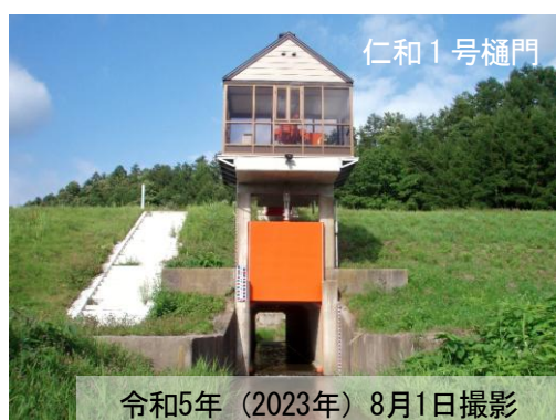
写真 2-3 浸水軽減対策（樋門の無動力化前）
