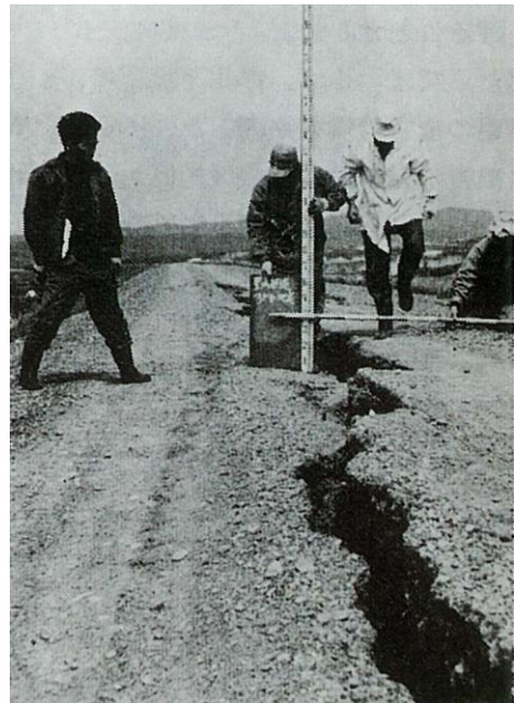
出典：鶴川沙流川治水史 写真 1-23 豊城地区堤防天端の亀裂 (昭和43年(1968年)十勝沖地震)
