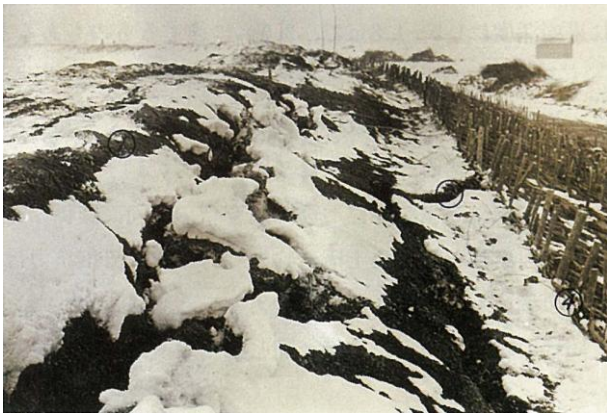
出典：鶴川沙流川治水史 写真 1-20 豊城築堤の亀裂 (昭和27年(1952年)十勝沖地震)
