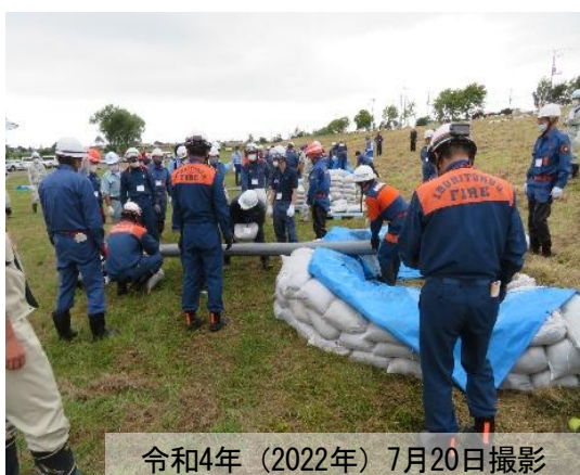
写真 2-35 月の輪工法
