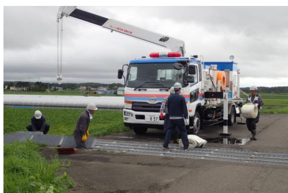
写真 2-1 ポンプ車による内水排除の状況 (汐見樋門、平成28年(2016年)8月洪水)
