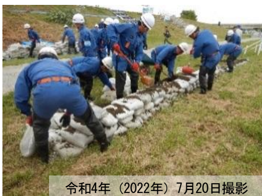
写真 2-33 防災機関による積み土のう工
