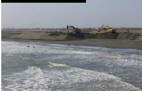
水制工 (袋型根固)
