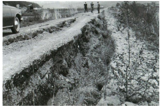
出典：鶴川沙流川治水史 写真 1-21 豊城築堤 堤防のすべり破壊 (昭和43年(1968年)十勝沖地震)
