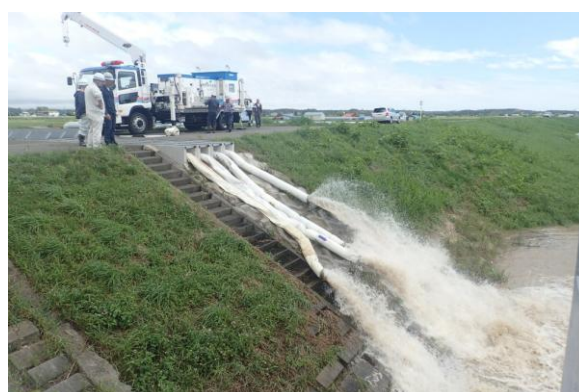
写真 2-2 ポンプ車による内水排除の状況 (汐見樋門、平成28年(2016年)8月洪水)
