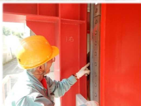
堤体・放流設備等の点検整備
