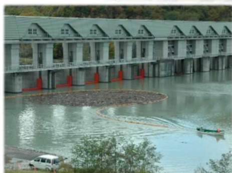
ダム湖内の流木回収
