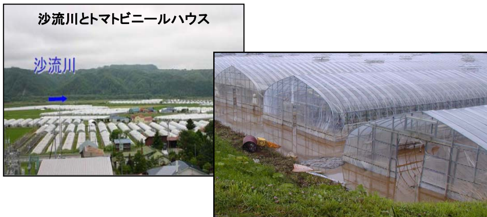
野菜地区の冠水被害状況(平成15年8月)
