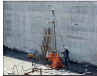
基礎地盤の割れ目を水が流れないように、事前に割れ目にセメントを流し込み、水が漏れないようにする。
