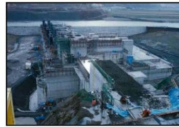
コンクリートをダンプトラックやケーブルクレーンで運び、ダムの形に固める。
