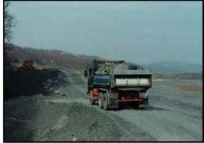
掘削した土砂やダムに必要な材料を運ぶためのトラックなどの通る道路をつくる。
