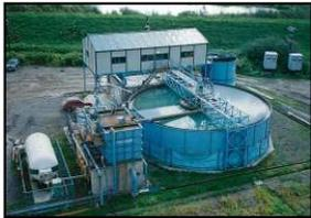
ダム工事に必要なコンクリートをつくる機械、汚れた水をきれいにする機械、それらに電気を送る機器などを設置する。これらの機械は工事の期間だけ設置し、工事が終わると撤去するので、「仮設備」と呼び、設置する場所は「仮設備ヤード」と呼ぶ。
