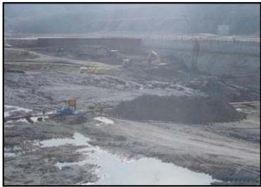
ダムが接してもよい基礎地盤まで、川の底や山の斜面の柔らかい土や岩盤を取り除き、コンクリートが接する部分の掃除をする。
