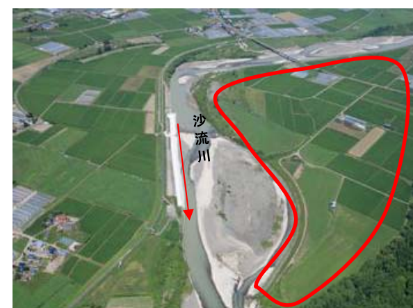
沙流川の堤防未整備箇所
