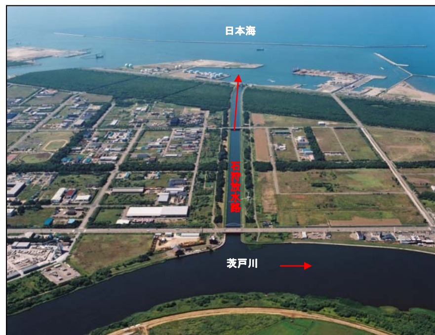
石狩川水系 石狩放水路の例
