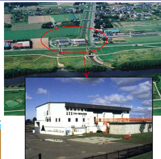
排水機場の例 (石狩川水系豊平川 雁来排水機場)
