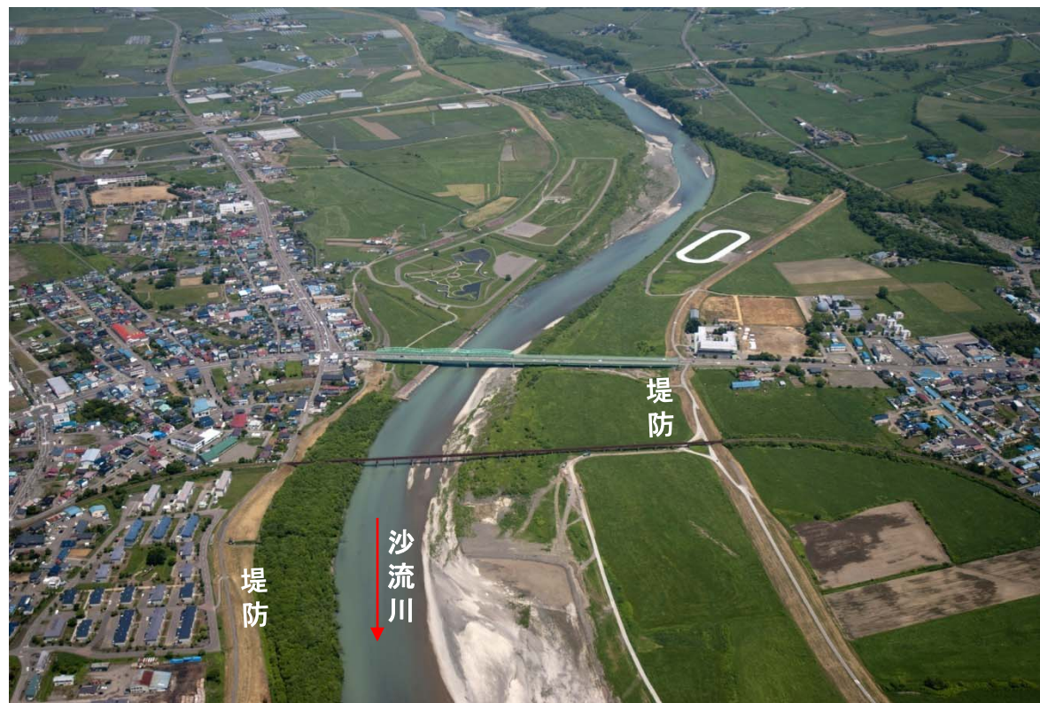
河川沿いの市街地の状況
