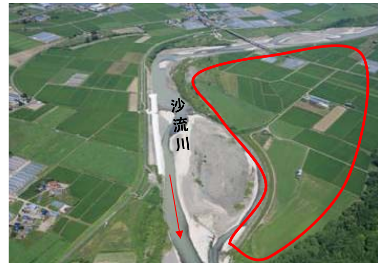
沙流川の堤防未整備箇所状況
