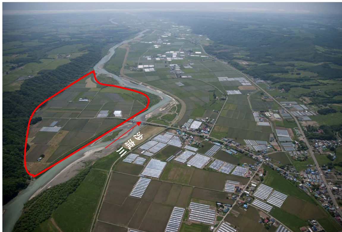
堤防未整備区間の状況
