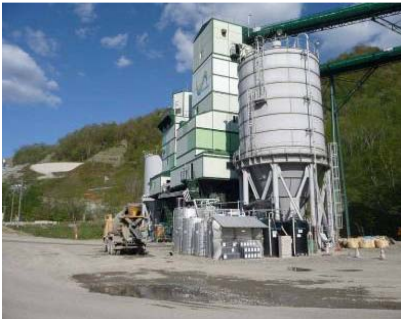
セメント貯蔵供給設備(イメージ)
